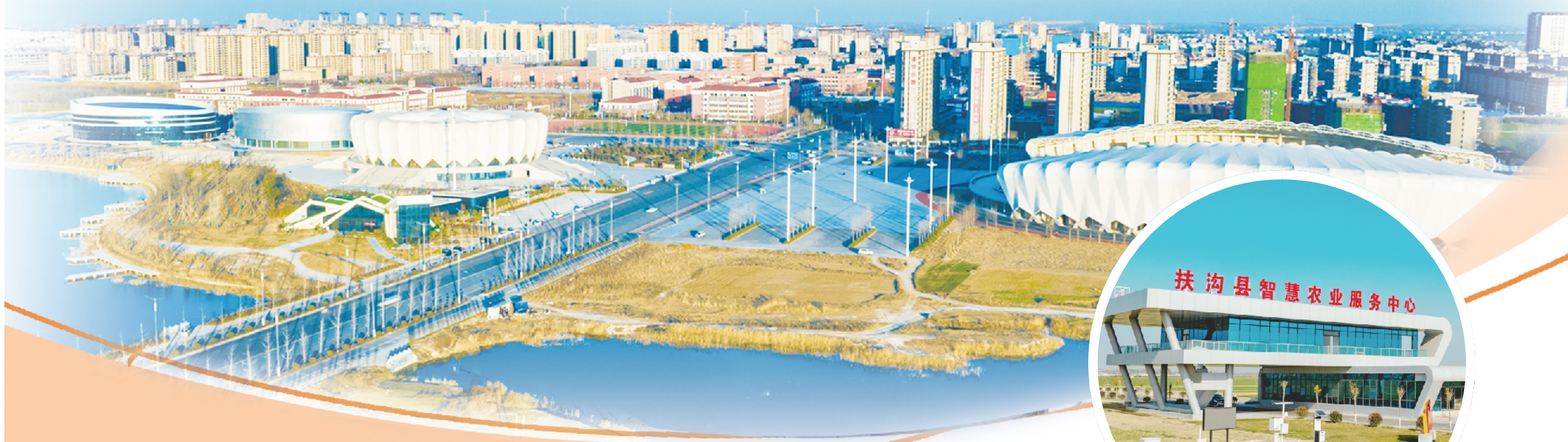
扶沟县“三馆一中心”俯瞰图。
